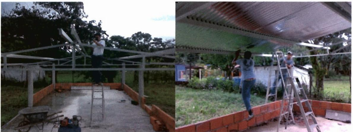
Figura N° 4-5 Construcción de Galpón (Techo dos aguas)
