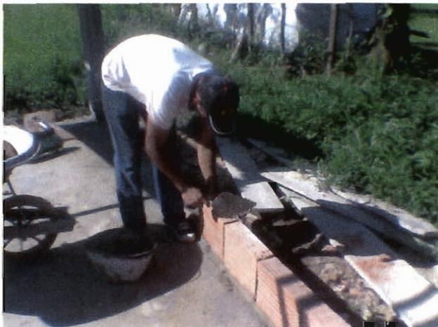
**Figura 28:** Maestro levantando las hiladas de ladrillos
