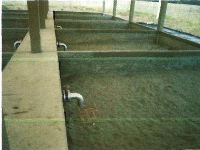
Fotografía 1.3 Instalaciones de la planta de tratamiento de aguas residuales del municipio de San Martín, la cual no se encuentra en funcionamiento.
