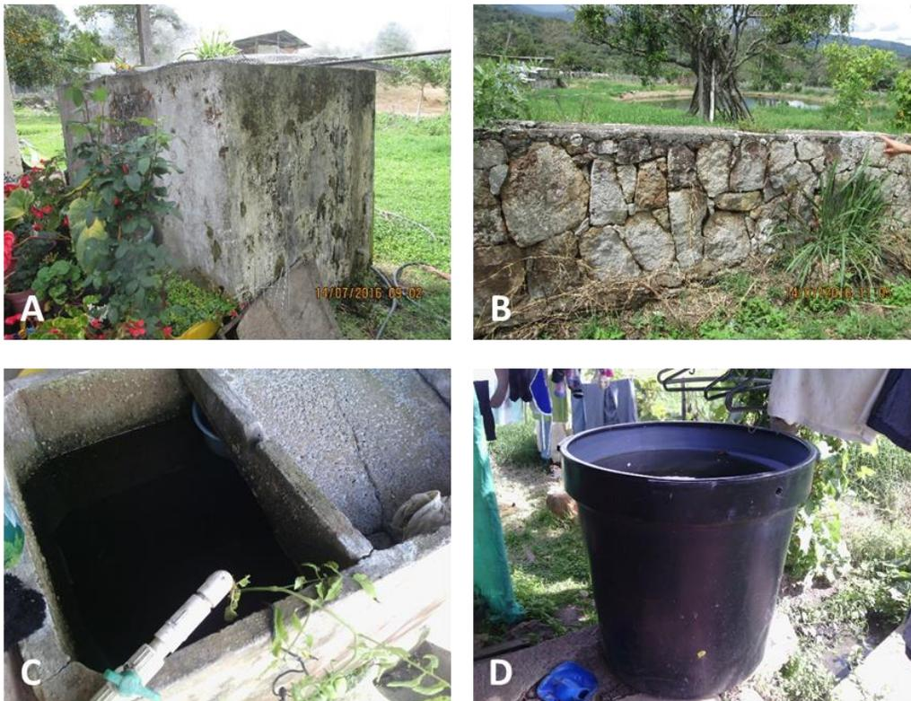
**Figura 12.** Tipos de reservorio encontrados en las zonas veredales del área de estudio. A) Reservorio de mampostería, B) Lago como reservorio asociado a cultivo transitorio, C) Reservorio de uso doméstico, D) Tanque plástico. (Fuente: el autor).
