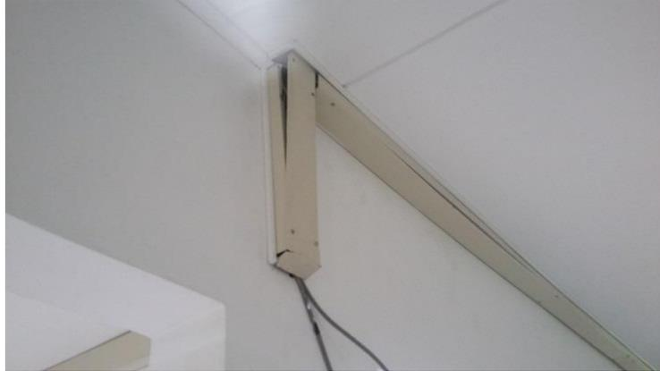
*Figura 44. Canaleta en mal estado*
