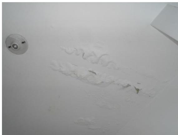
*Figura 30. Humedad en el área de ecografías*
