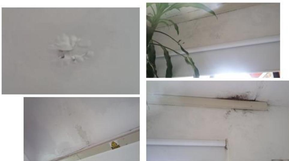
*Figura 43. Humedad en la zona de cableado eléctrico*
