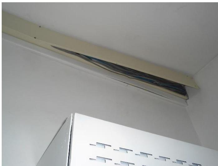
*Figura 29. Cables canalizados en mal estado*
