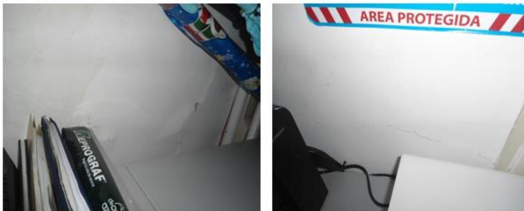
*Figura 13. Paredes agrietadas en la oficina de asistente de gerencia.*
