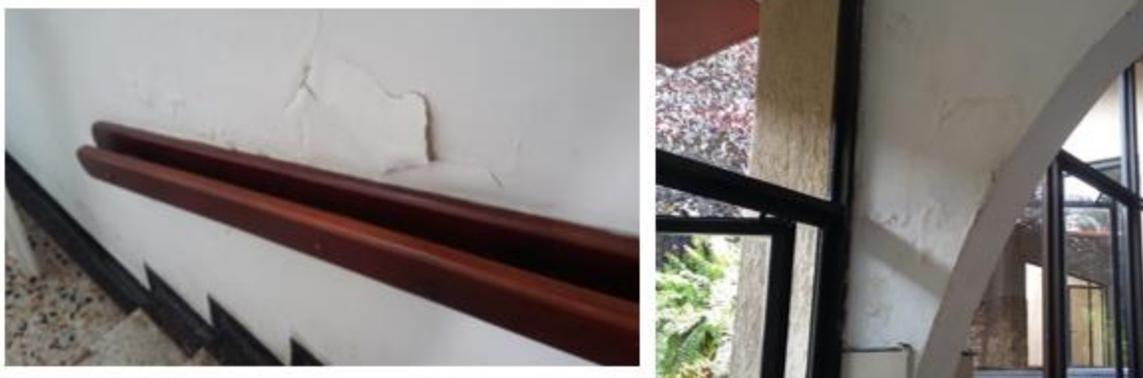
*Figura 41. Humedad y agrietamientos en la sala de espera de atención al usuario*
