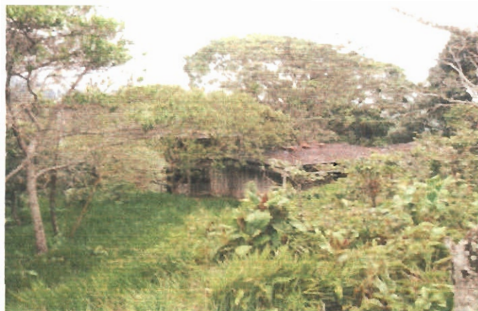
Figura N° 8. Casa en la vereda San Pedro en estado de abandono.
