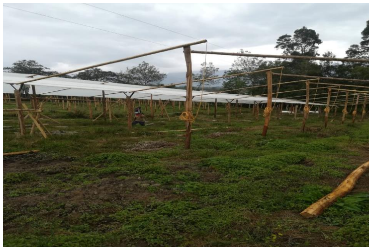
Figura 2 Construcción de invernadero tipo capilla
