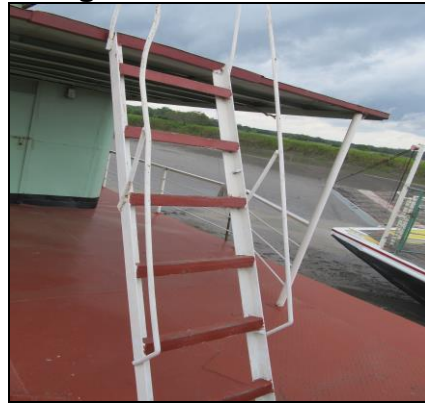
Fotografía 2. Escalera de acceso
