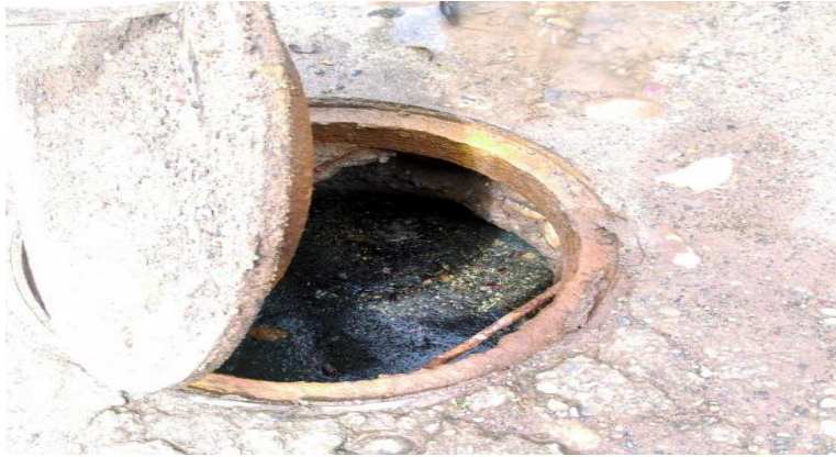
Fotografía 5. Alcantarilla rebosada y con tapa con fisurada. .
