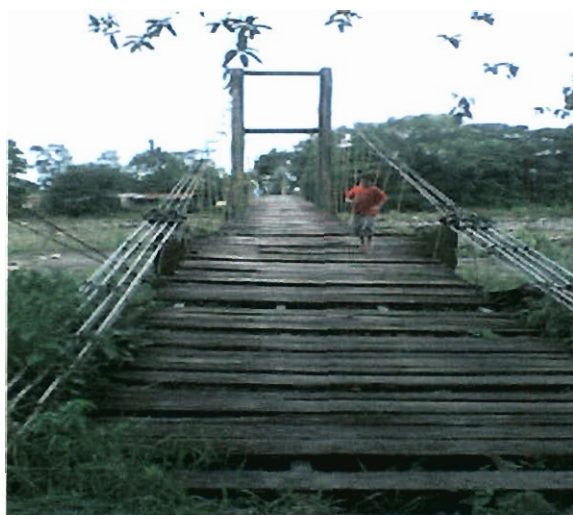
Foto 13. Puente sobre Rio Guacavia
