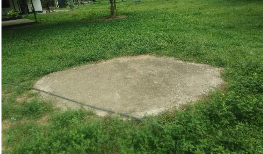
Figura 39. Sistema de tratamiento de aguas residuales (pozo séptico).
