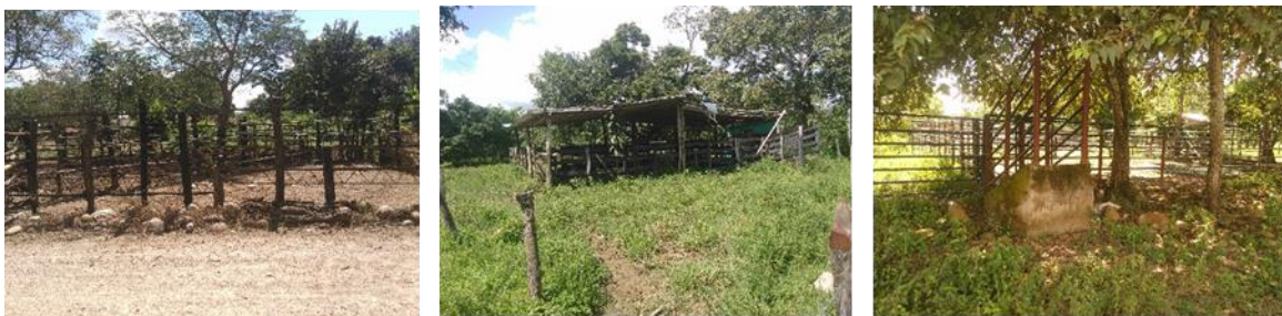
Figura 7. Corral en regular estado construido en madera, hierro y guadua (izquierda). Corral establo construido en madera y techo en zinc (centro). Corral construido en tubería de hierro en buen estado (derecha).
